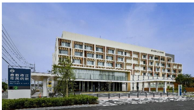
倉敷市立市民病院(平成 30 年 4 月)
