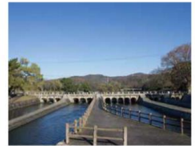
高梁川東西用水取配水施設
