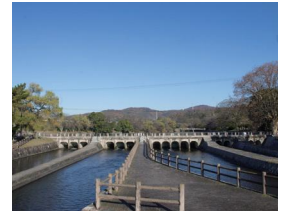
高梁川東西用水取配水施設
