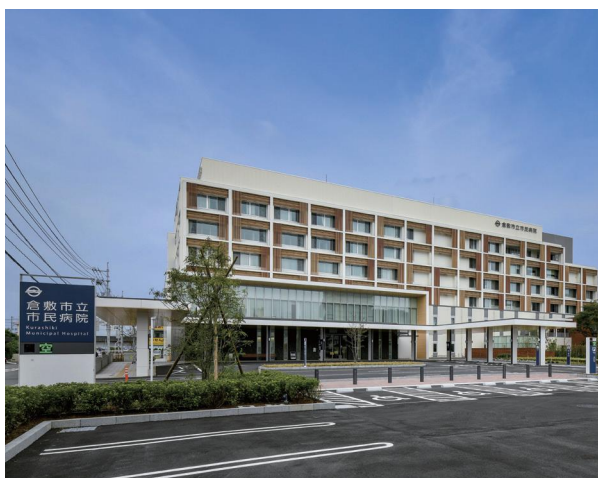
倉敷市立市民病院(平成30年4月)
