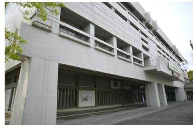
写真1 スパン20mを超える梁とプレキャストコンクリートの装飾。
