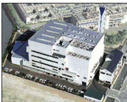
水島清掃工場
