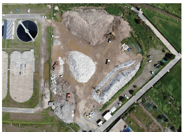
真備浄化センター（9月5日）
