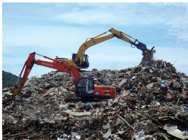
重機による積み上げの様子
