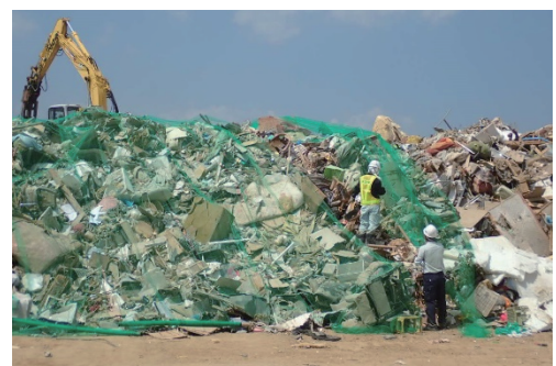
飛散防止のためネットを張る様子
