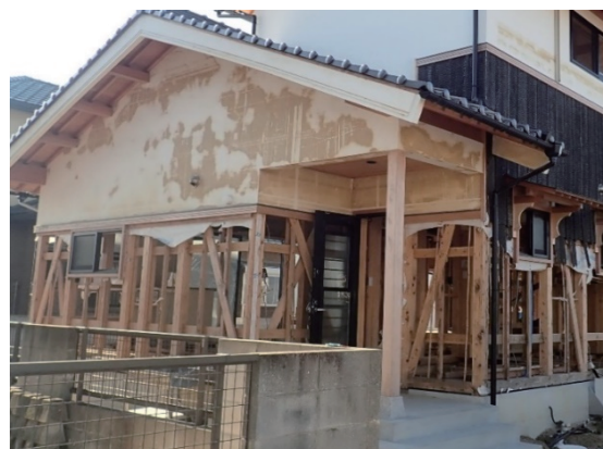
各所で見られたスケルトン解体された家屋
