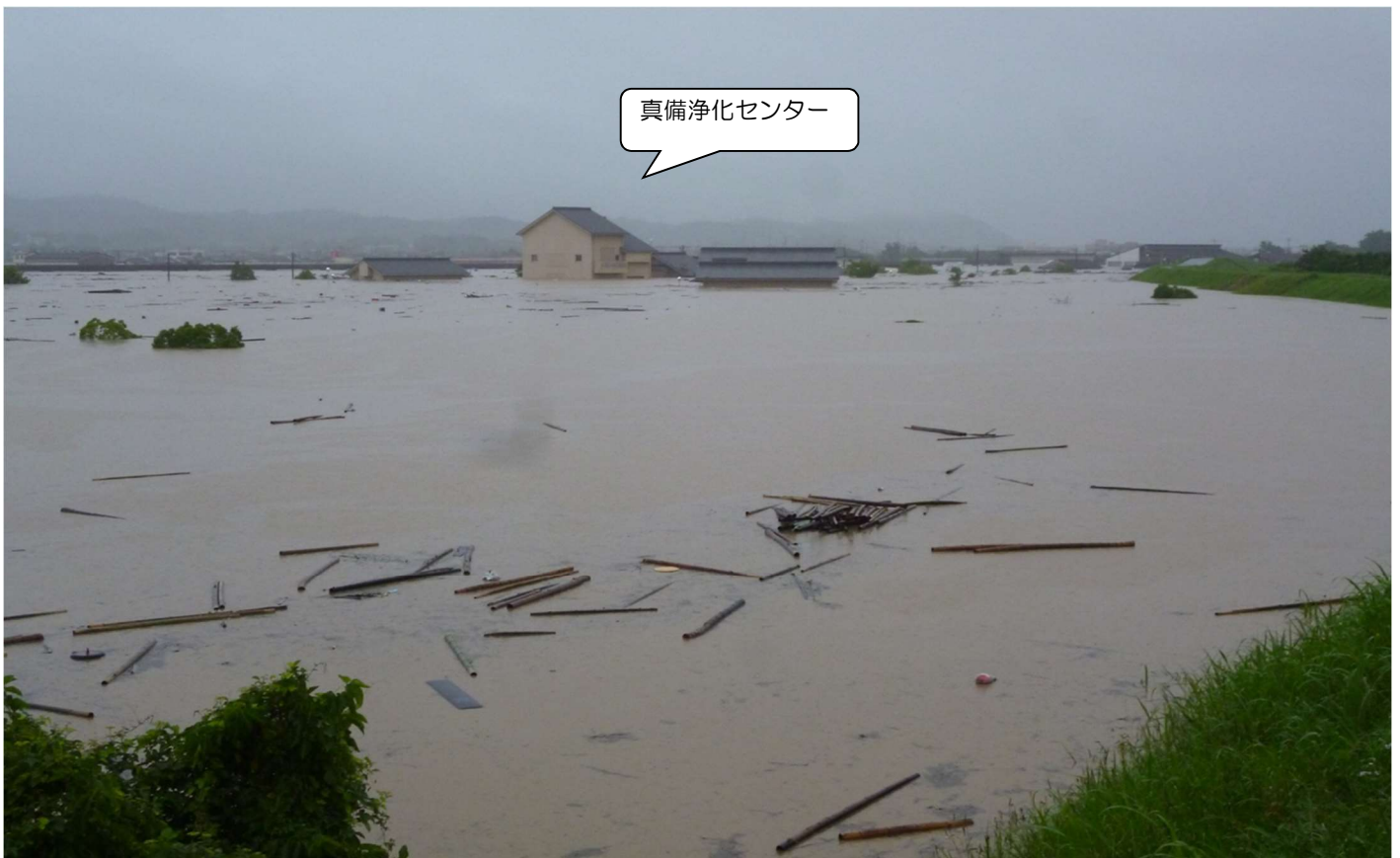
図 2. 真備浄化センターの被災状況
