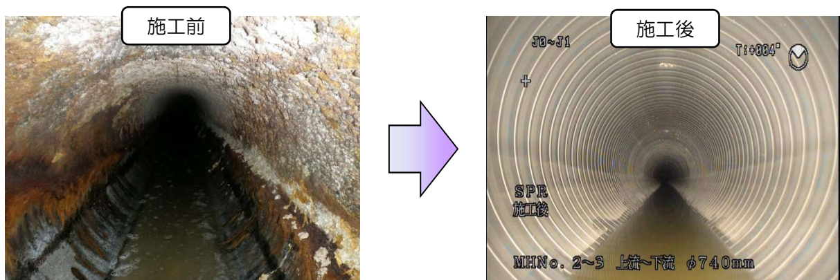
図3.下水道施設の耐震化（例）
