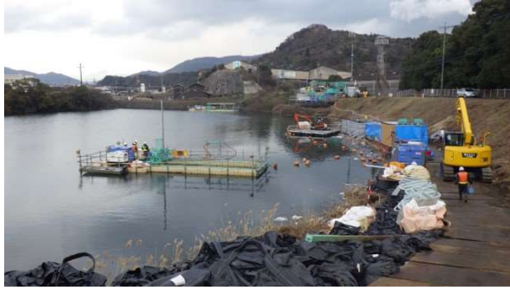
写真 3.3 南畝板敷排水機場遊水池の浚渫状況
