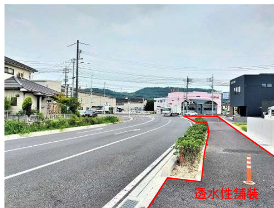
写真 3.5 (都)西阿知矢柄線歩道の透水性舗装
