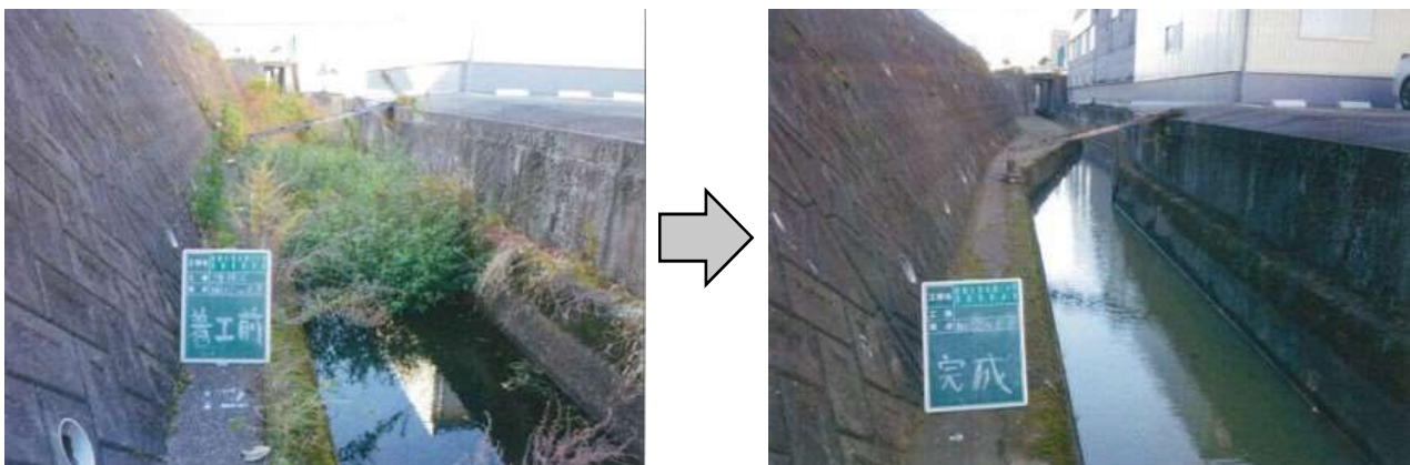
写真 3.2 土砂等撤去状況
