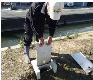
堰板等設置状況(ほ場)
