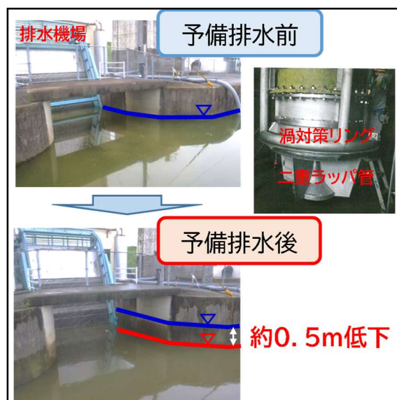
農業用排水機場ポンプ施設の改良
