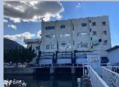
福田呼松第2排水機場
