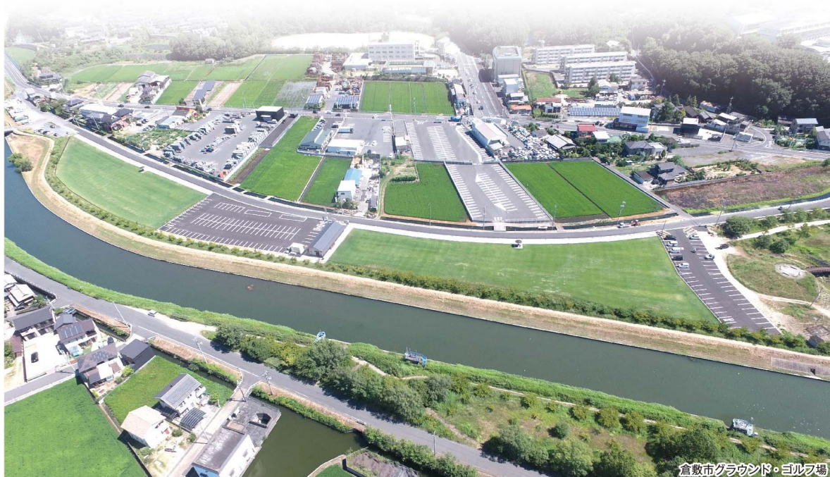
倉敷市グラウンド・ゴルフ場
