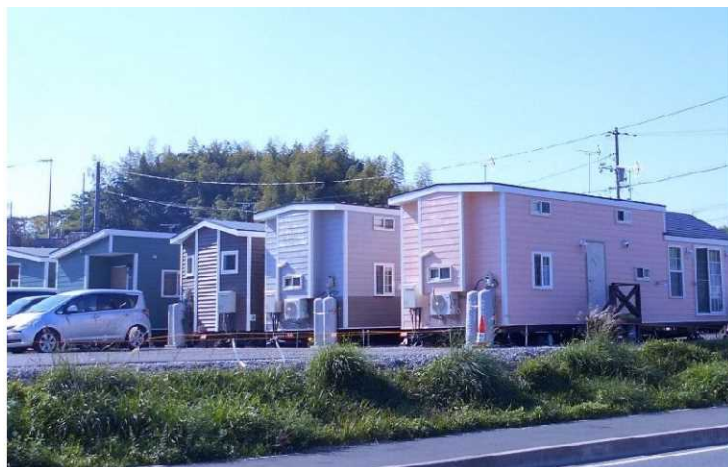
柳井原仮設団地の建設型仮設住宅（トレーラーハウス）：船穂町柳井原
