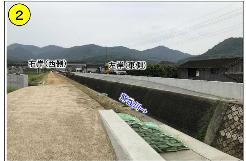
小田川の背水影響を低減するための堤防かさ上げ工事が令和3年5月末に完了
