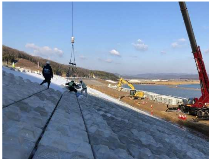
令和4年2月 締切堤防の護岸整備
