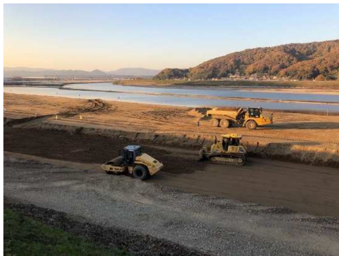
令和3年11月 締切堤防の盛土工事
