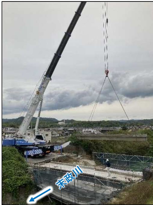
(1) 既設橋梁 撤去
