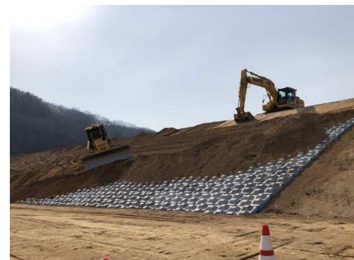
令和4年3月 締切堤防の堤防整備
