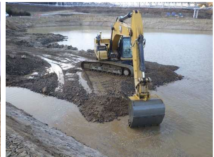
令和4年2月 新合流点の掘削
