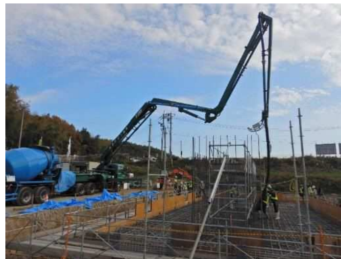
令和2年12月 橋台コンクリート工事
