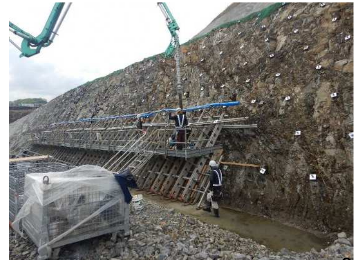
令和4年4月 南山法面保護
