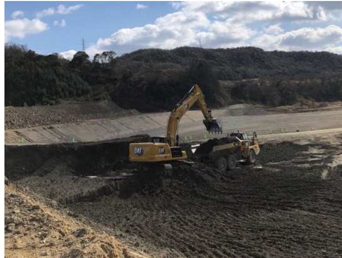
令和4年2月 酒津地区の掘削
