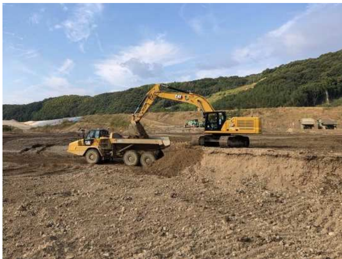
令和3年10月 酒津地区の掘削
