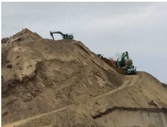
令和2年1月23日に本格的な掘削に着手
