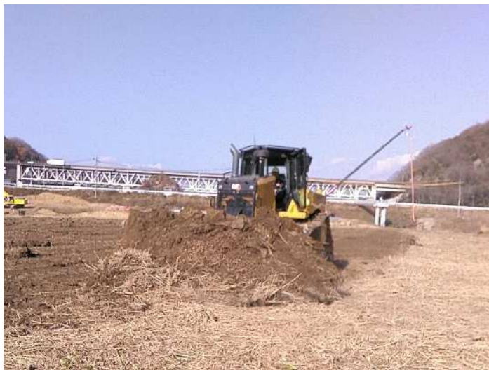
令和3年12月 新合流点の掘削
