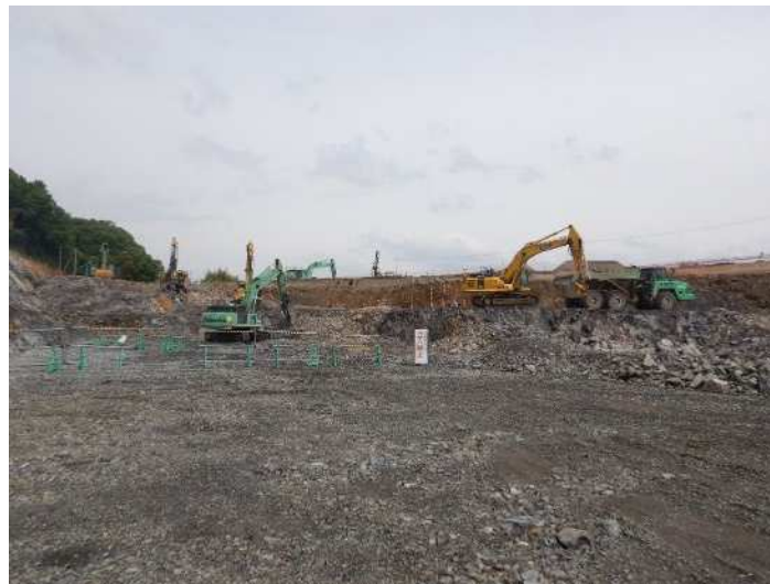
令和4年4月 南山の掘削
