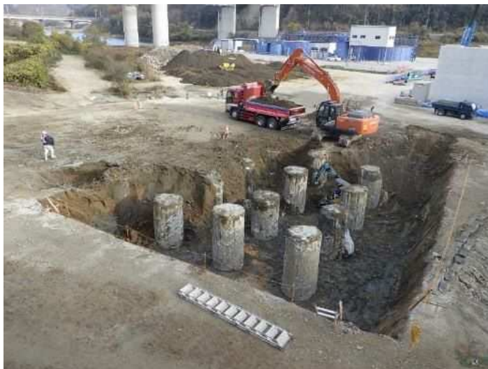
令和2年12月 橋台の基礎杭工事
