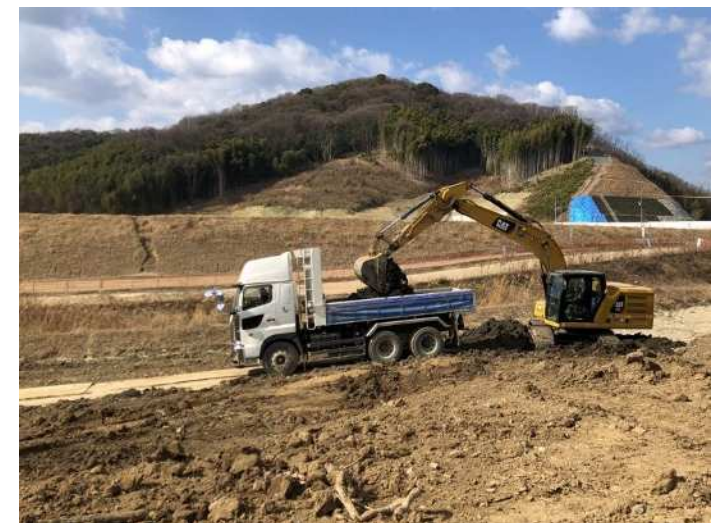
令和4年2月 酒津地区の掘削
