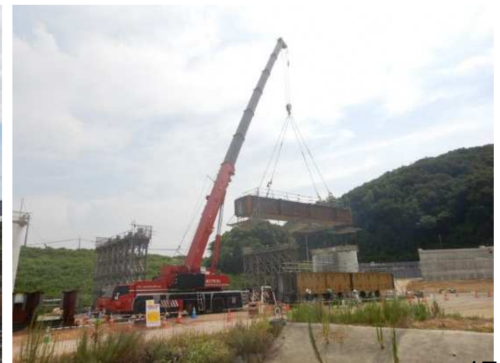
令和3年8月 橋桁の架設
