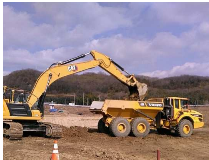
令和4年1月 新合流点の掘削
