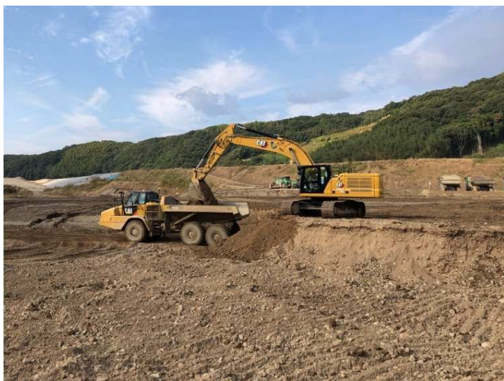
令和3年10月 酒津地区の掘削
