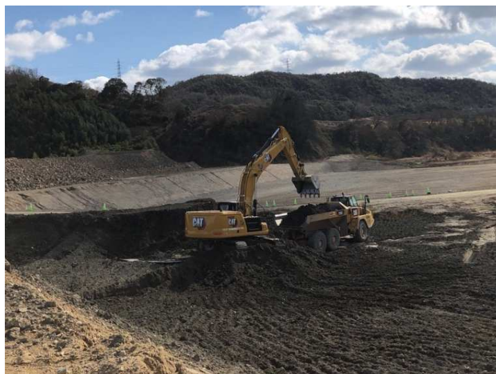
令和4年2月 酒津地区の掘削
