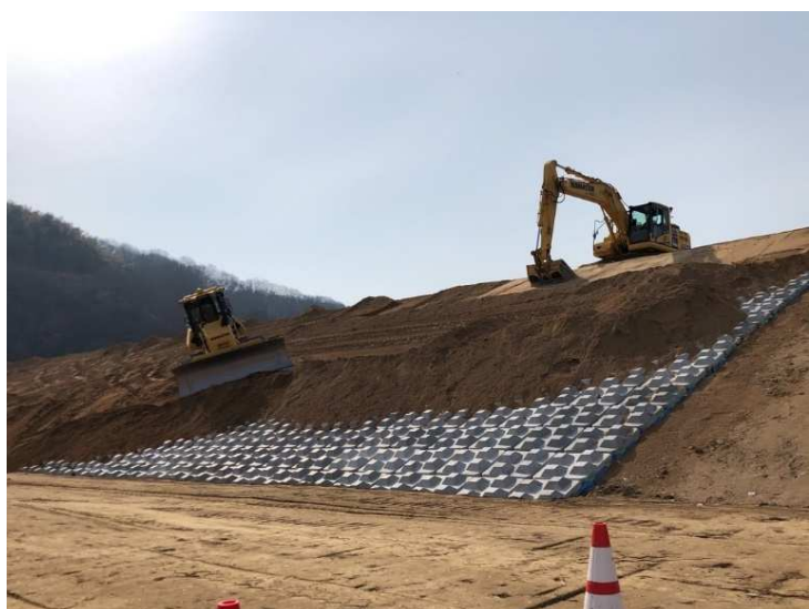
令和4年3月 締切堤防の護岸整備
