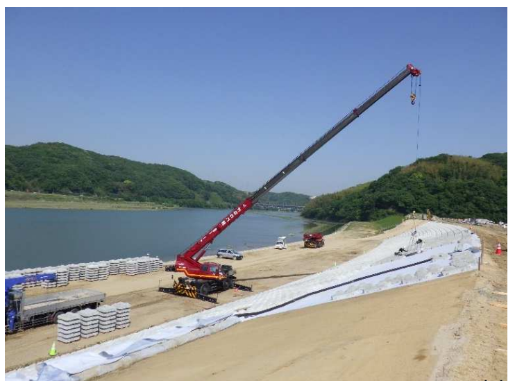
令和5年5月 締切堤防の護岸整備
