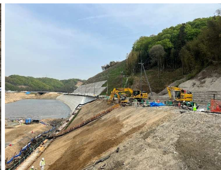
令和5年4月 南山護岸整備
