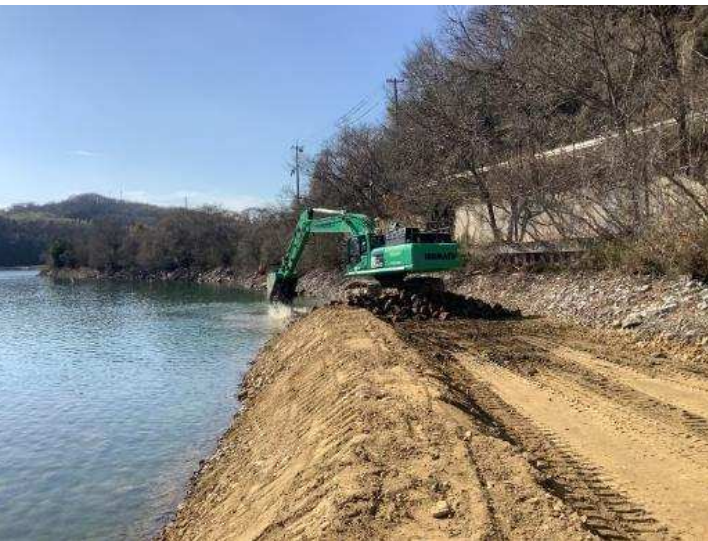
令和2年2月 柳井原地区堤防基盤の岩砕投入
