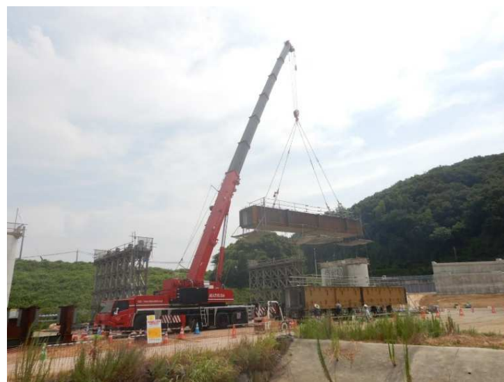
令和3年8月 橋桁の架設
