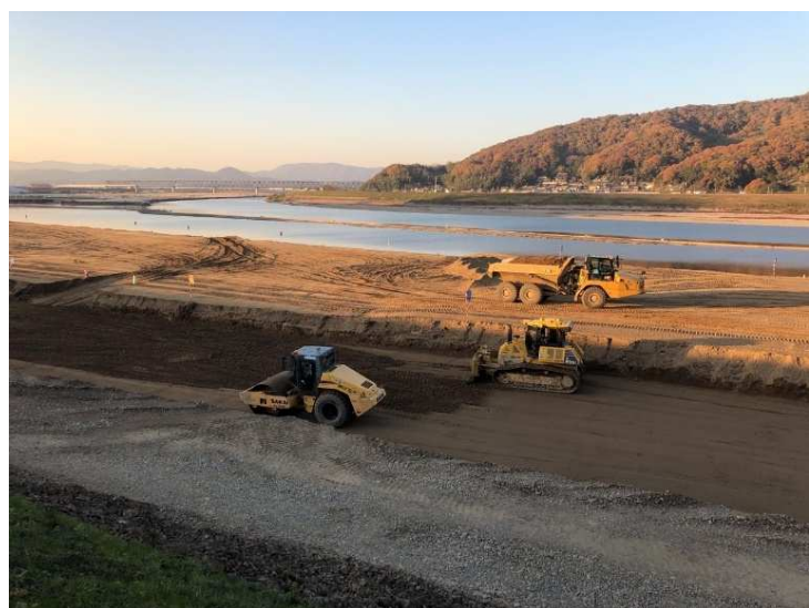
令和3年11月 締切堤防の盛土工事
