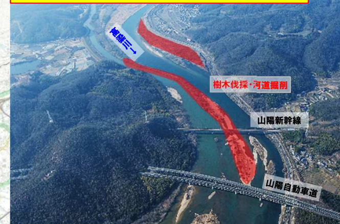
清音古地箇所(樹木伐採・河道掘削)
