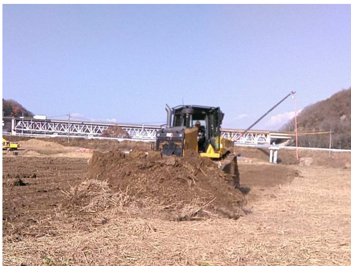
令和3年12月 新合流点の掘削
