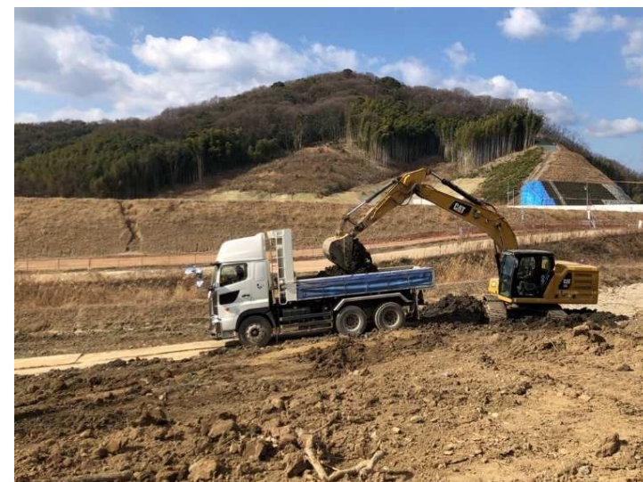
令和4年2月 酒津地区の掘削
