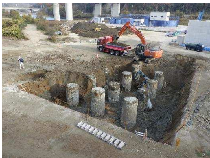
令和2年12月 橋台の基礎杭工事
