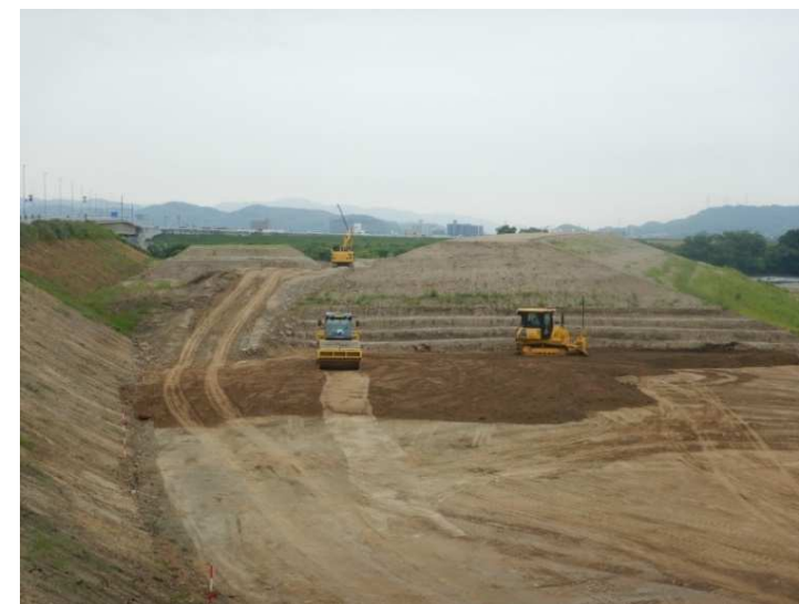
令和5年5月 新合流点の堤防整備
