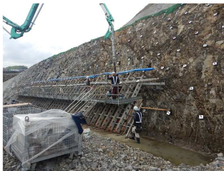
令和4年4月 南山法面保護
