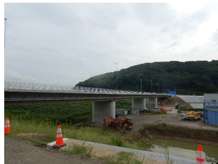
令和4年8月 橋桁架設完了
