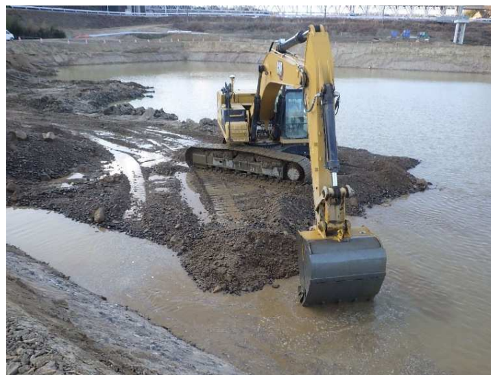
令和4年2月 新合流点の掘削
