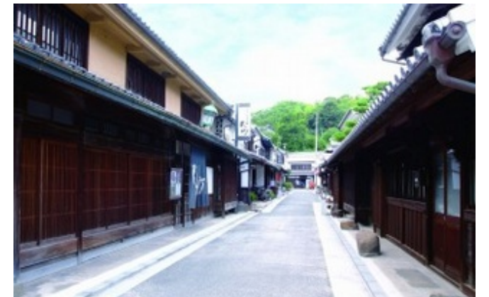
〔電線類の地中化〕
