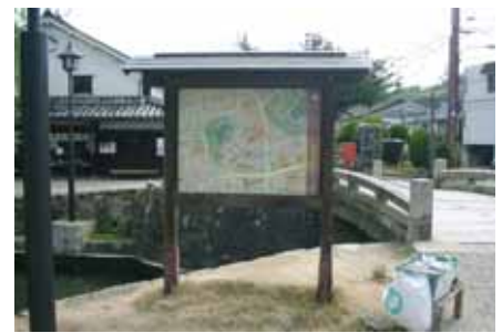
サイン設置場所に段差・傾斜があり、車いす使用者等は近づけない
