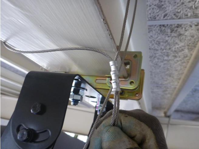
かしめ個所数が適正であることがわかるように写真を撮影する
