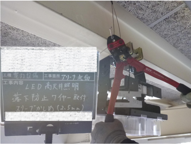
落下防止ワイヤーが構造体に取り付けられていることがわかるように写真を撮影する
