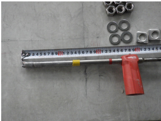
（3）アンカーボルト削孔径の確認
