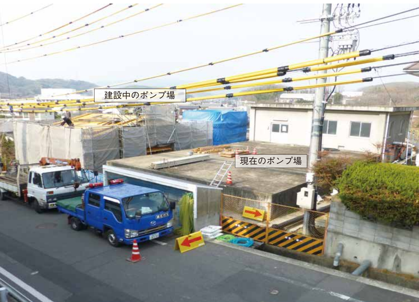
▲更新中の勇崎加圧ポンプ場（玉島柏島地内）
