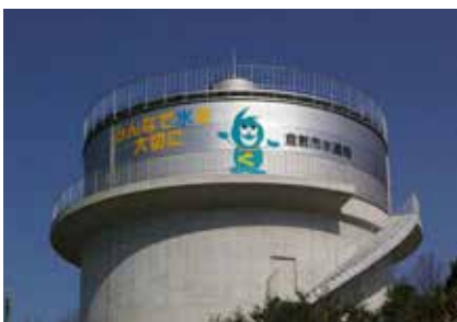
▲耐震性のある高架水槽
