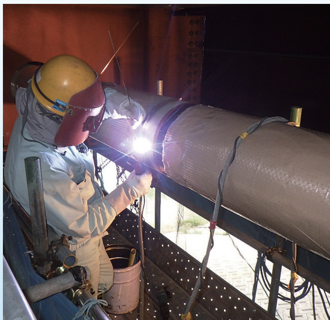
◆高梁川に架ける水道管の溶接作業
