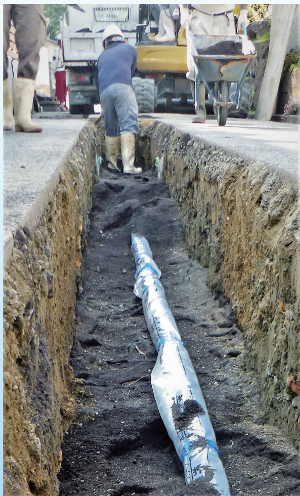
◆新しい水道管に取り替え中
