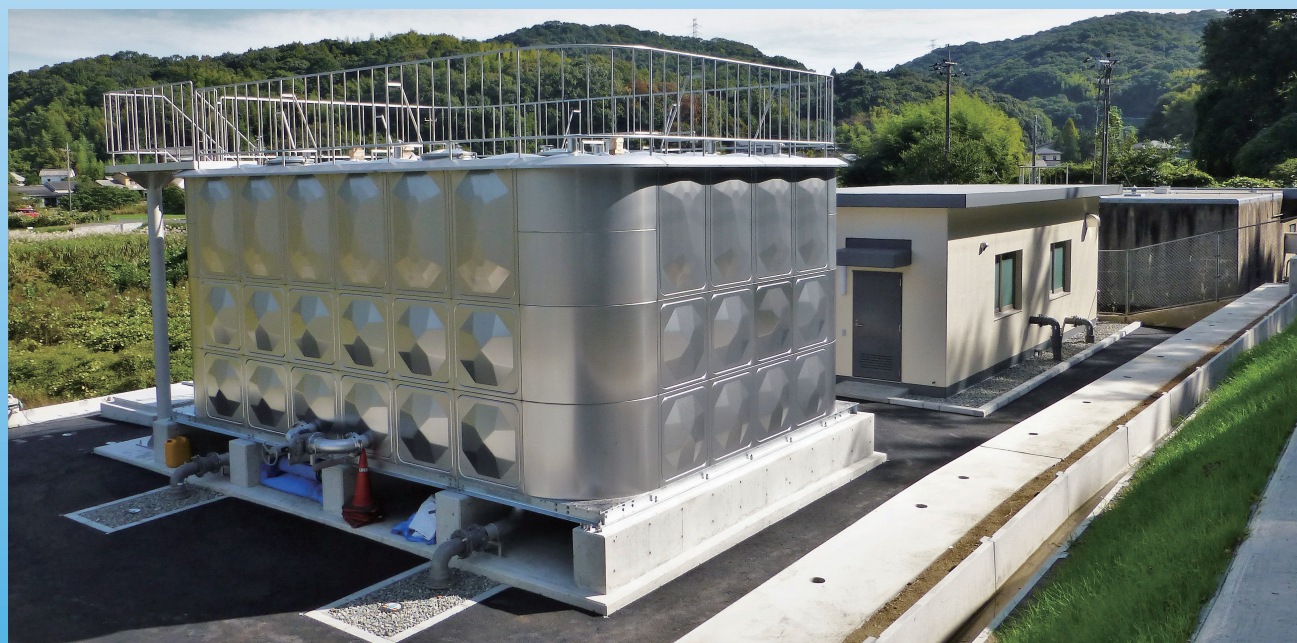
◆完成間近の西原加圧ポンプ場（尾原地内）
