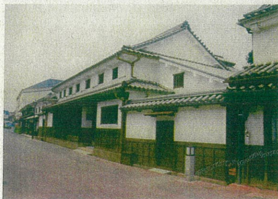
保存修理工事後
