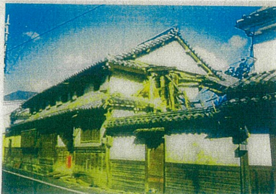
保存修理工事前
