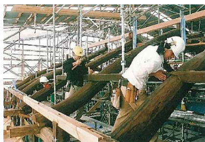
井上家住宅保存修理事業の様子
