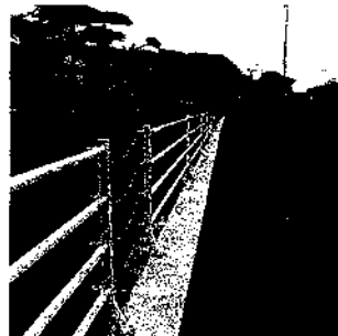
転落防止柵が設置されま した。(玉島上成)
