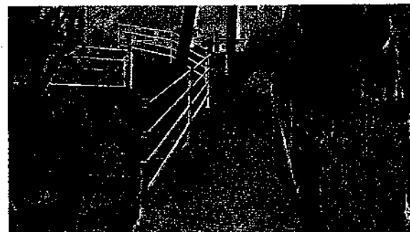
児島柳田町地内の急こう配の通路に手摺が設置されました。転倒防止の役割を果たす手摺です。高齢者の方からの要望に応えることが出来ました。
