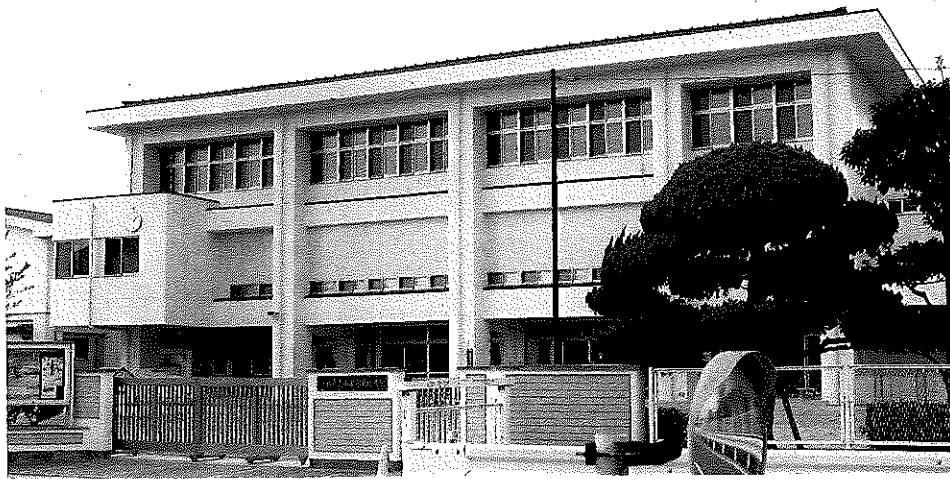
▲完成した複合施設（二階＝新体育館／一階＝新園舎）
