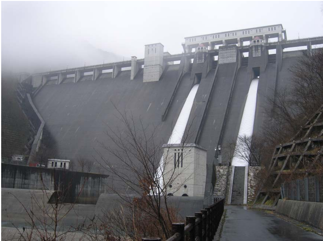
千屋ダム（新見市）
