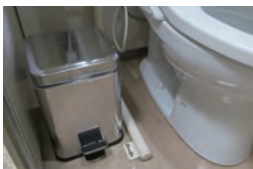
本庁舎内男子トイレに設置のサニタリーボックス
