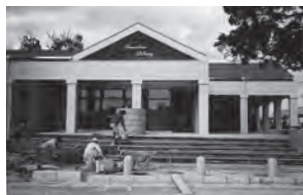
▲建設中の玉島図書館
