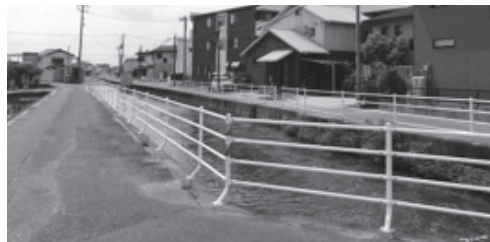
▲転落防護柵の設置
