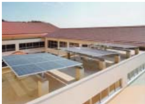
太陽光発電システムの設置 市立長尾小学校（5kW）
