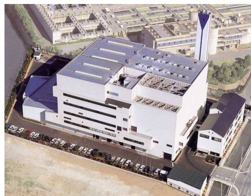
水島清掃工場
