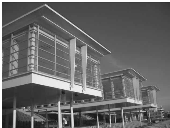
環境交流スクエア 西棟 4階部分
