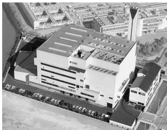
水島清掃工場
