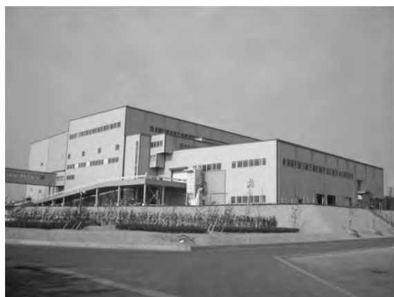
倉敷市資源循環型廃棄物処理施設
