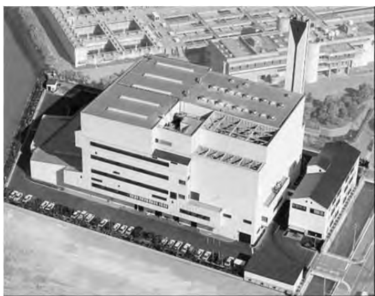
水島清掃工場
