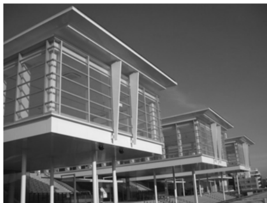
環境交流スクエア 西棟 4階部分
