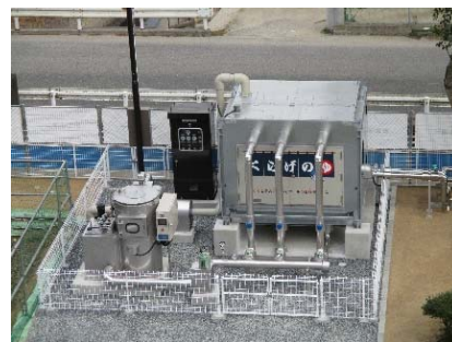
下水熱交換器の外観
