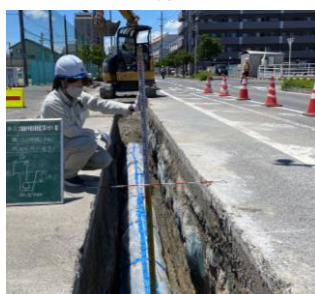
▲水道管の耐震化工事
