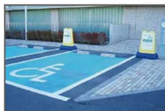
車いす使用者用駐車施設
