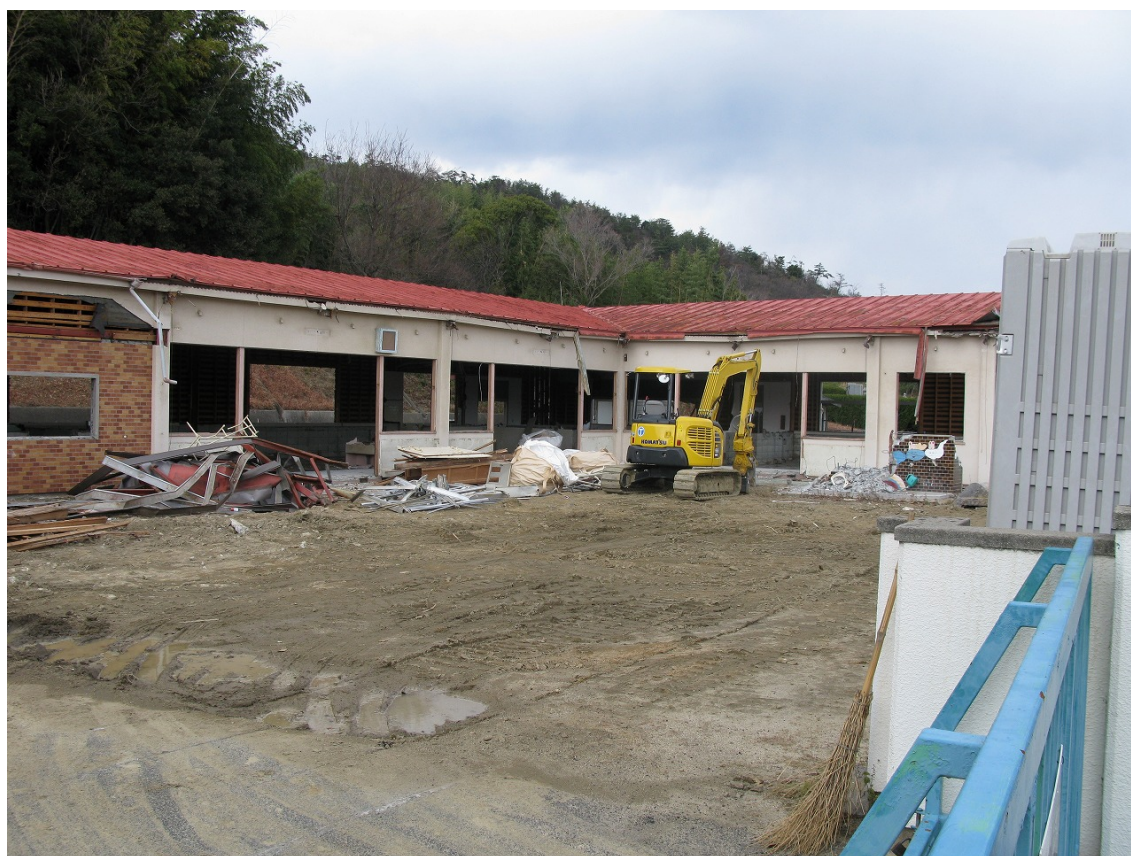
建物の解体作業中
