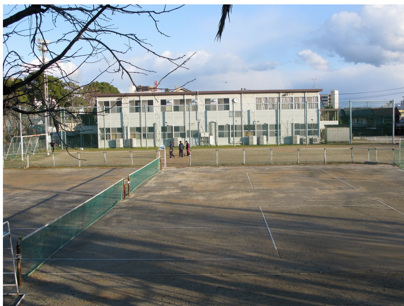
プレハブの建物の他には広い校庭だけが目立つ
