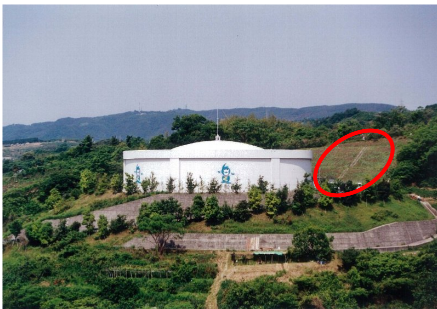
着手前法面（配水池タンクより南東から望む）
