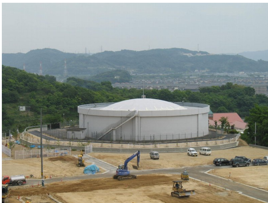
法面撤去後（配水池タンクより北西から望む）
