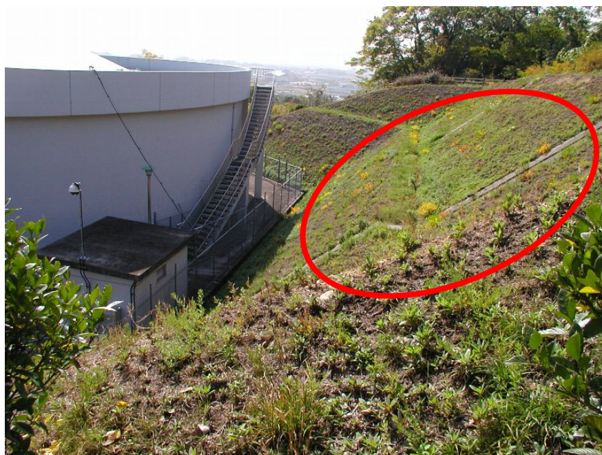
着手前法面（配水池タンクより北東から望む）
