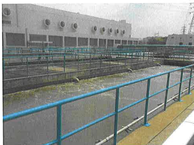
水島下水処理場
