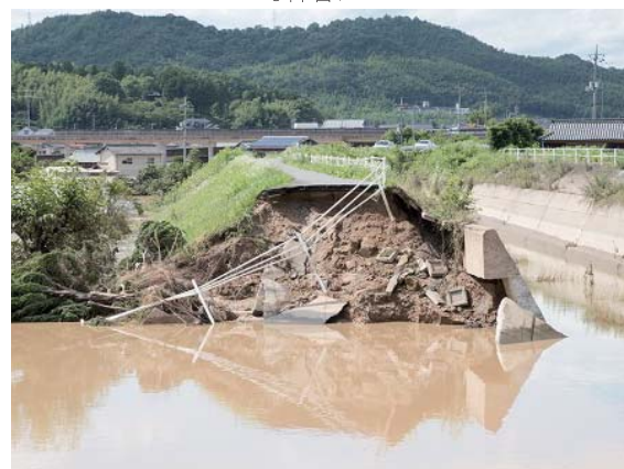
濁流により決壊した堤防 堤防が決壊すると、あっという間に家屋への浸水が進みます。決壊が所付近では、土砂の流入や家屋の損壊が…
