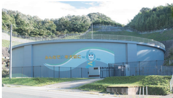
▲西之浦第2配水池
