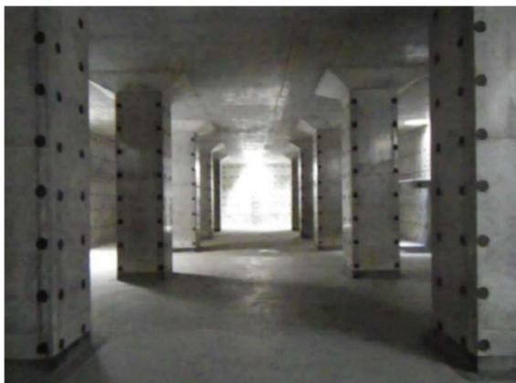
写真 3.4 倉敷駅東雨水貯留施設の内部
