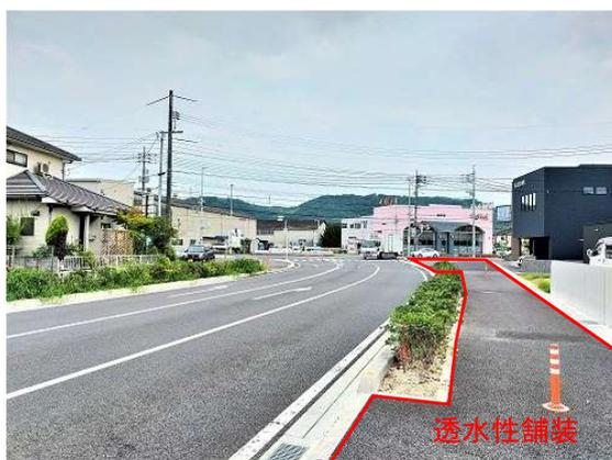
写真 3.6 (都) 西阿知矢柄線歩道の透水性舗装
