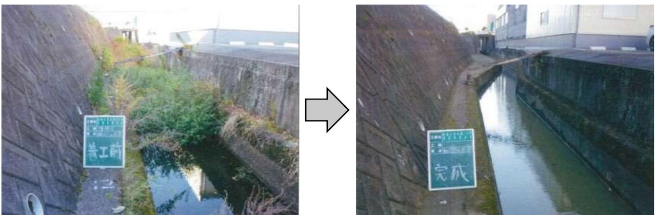
写真 3.2 土砂等撤去状況
