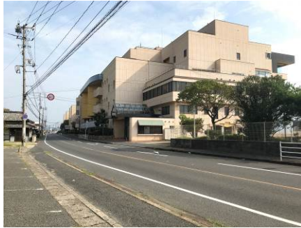
D. 県道 21 号線からのスタンド棟
