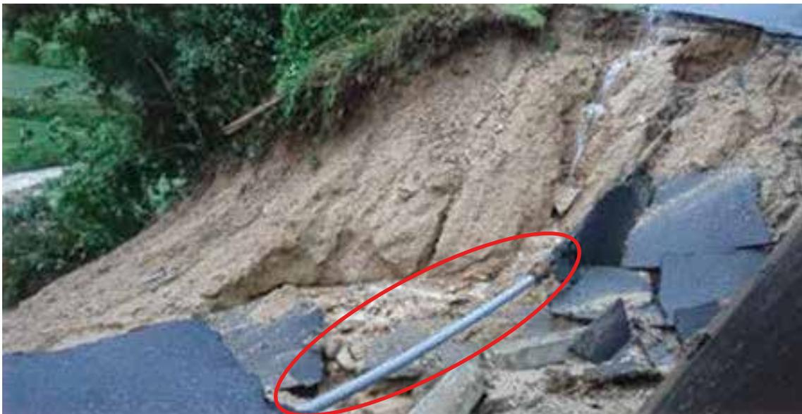
[空気弁の漏水]
