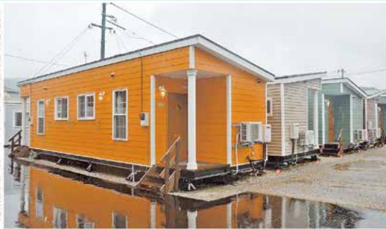
倉敷市船穂町柳井原で整備されたトレーラーハウス型の仮設住宅
