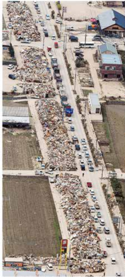
災害ごみが山積みされた道路に車列が続く倉敷市真備町地区中心部。12日午後2時30分
