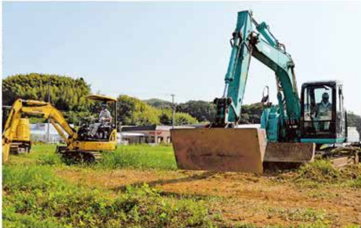
着工され、重機を使った整地作業が行われる仮設住宅の建設予定地。3日午前9時14分、倉敷市船穂町井原
