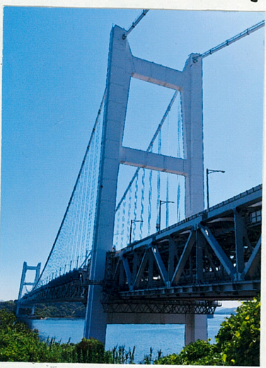
下津井から見上げる瀬戸大橋も圧巻!!
