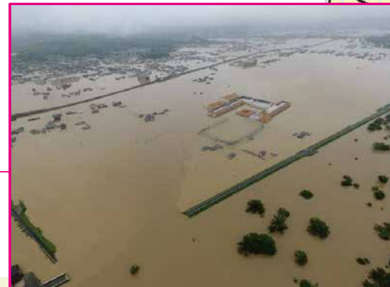
平成 30 年 7 月 真備地区 豪雨による堤防決壊浸水被害
